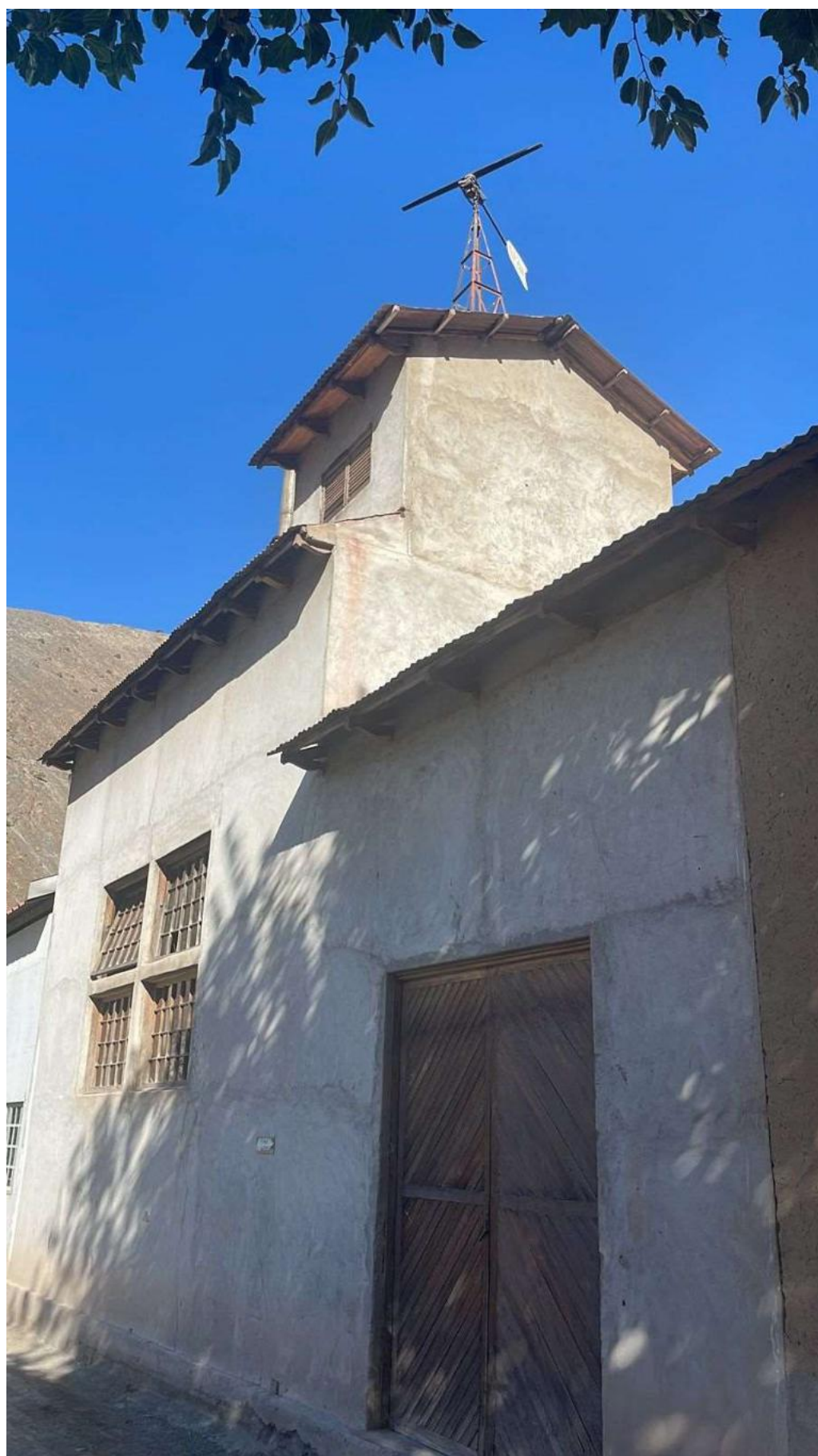
Figura 29. Muros de adobe asentado, de quince metros de altura. Destilería de Horcón Quemado . Foto: Eduardo Mulet.
