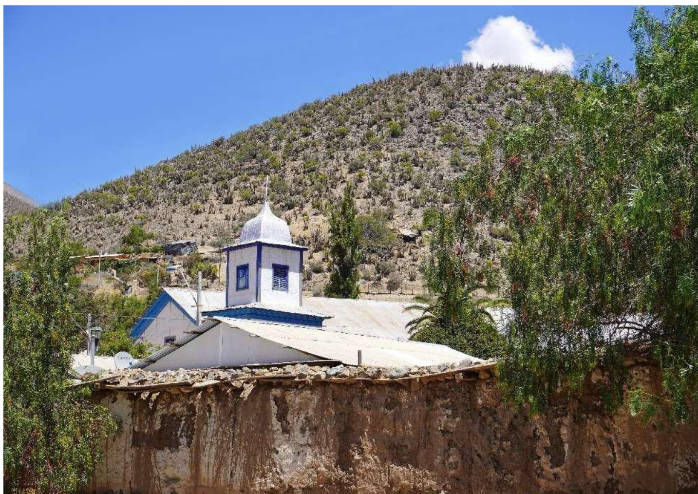
Figura 15. Campanario de la iglesia de Tulahuén, muro de adobe y pimiento. Foto: AKB.
