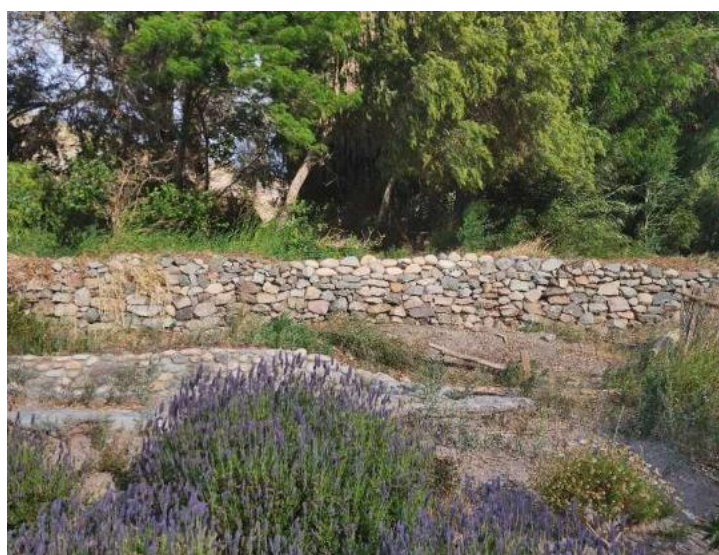
Figura 12: Cierre perimetral de pircas de pisquera Armidita . Foto: Robinson Ramírez.
