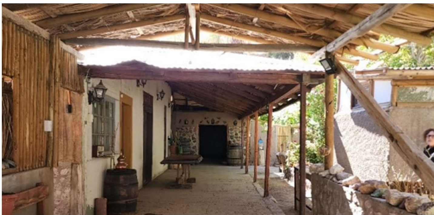
Figura 5: Salón principal de hacienda Armidita con techos de totora. Foto: Robinson Ramírez
